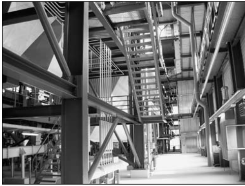
Les installations de la chaudière (vapeur à 400°C et 48 bars de pression)
